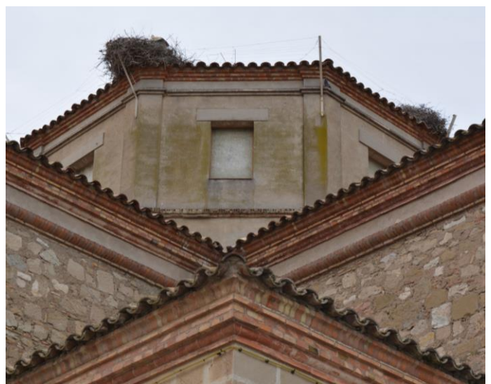
La retirada de nius i l'accés a coberta s'ha de fer a través d'una grua amb un braç mecanitzat de grans dimensions i una plataforma
