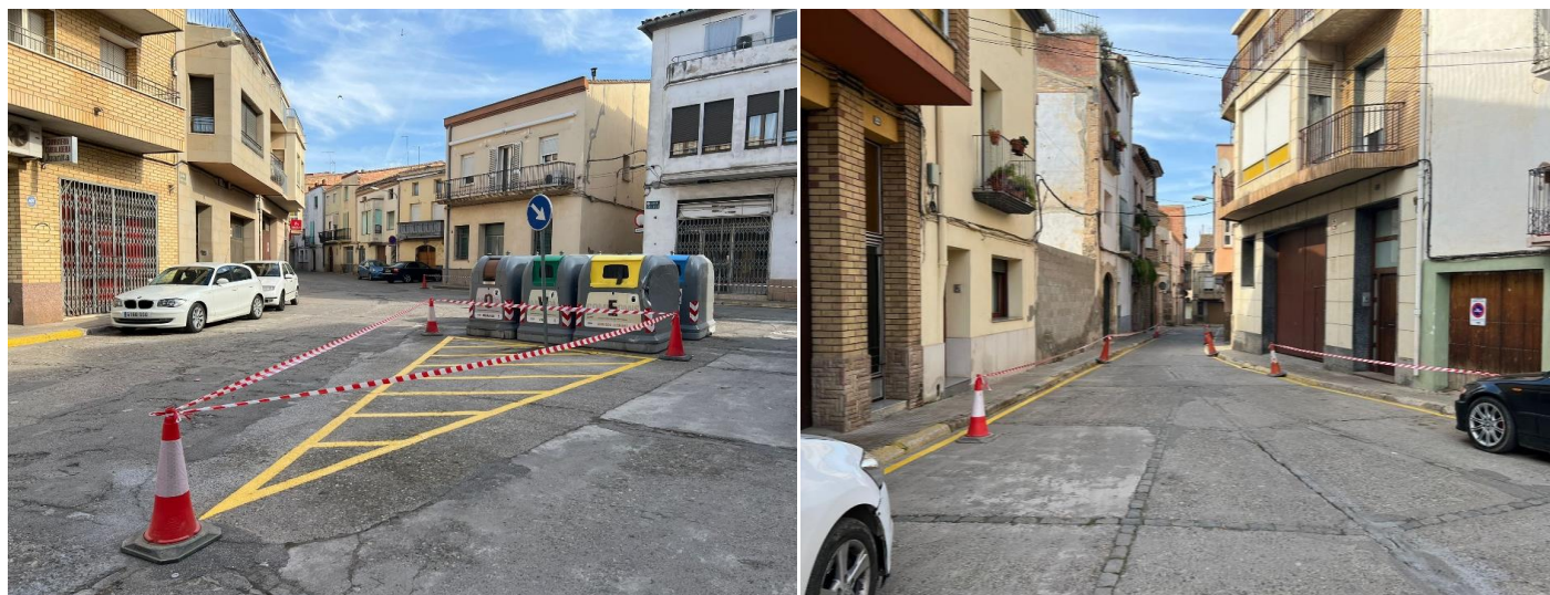
Imatge de l'actuació finalitzada amb les senyalitzacions, en groc, de prohibit estacionar vehicles
