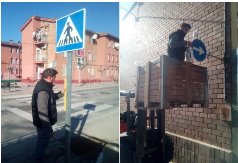
Reparació i col·locació de nova senyalització vertical per garantir una correcta circulació
