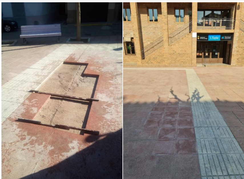
Retirada de l'enrajolat malmès i substitució per un de nou
