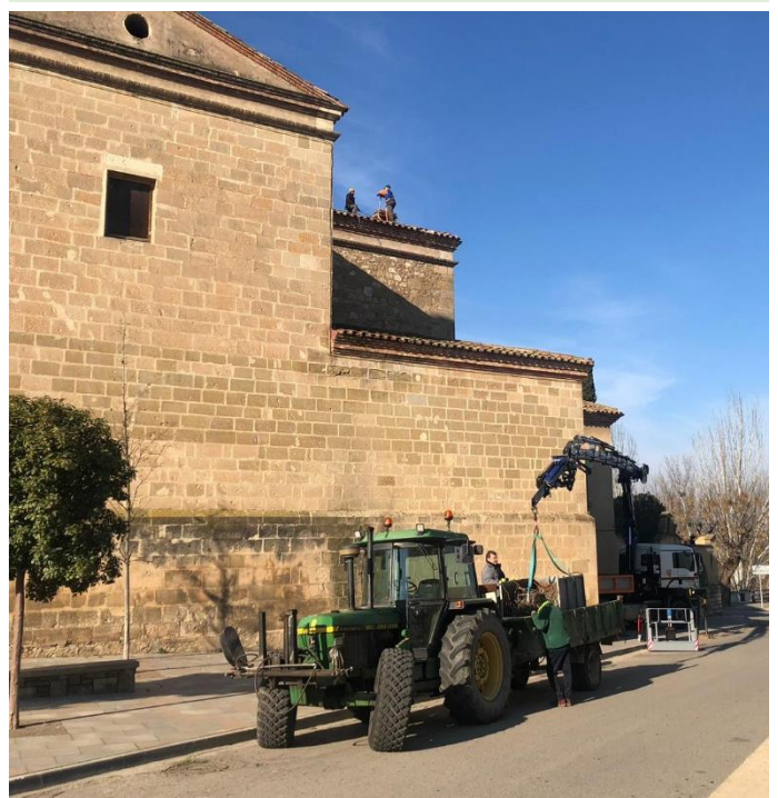
La retirada de nius i l'accés a coberta s'ha de fer a través d'una grua amb un braç mecanitzat de grans dimensions i una plataforma
