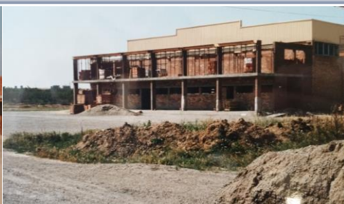
Construcció de la darrera fase, l'annex d'entrada
